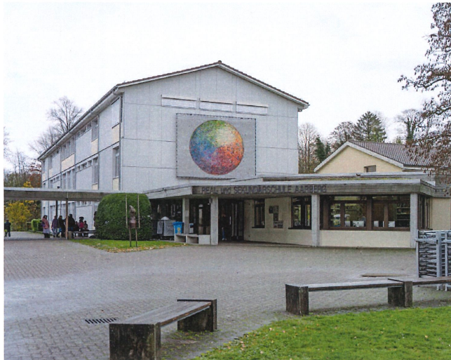
Das Projekt für das neue Oberstufenzentrum baut auf den bestehenden Gebäuden auf.
