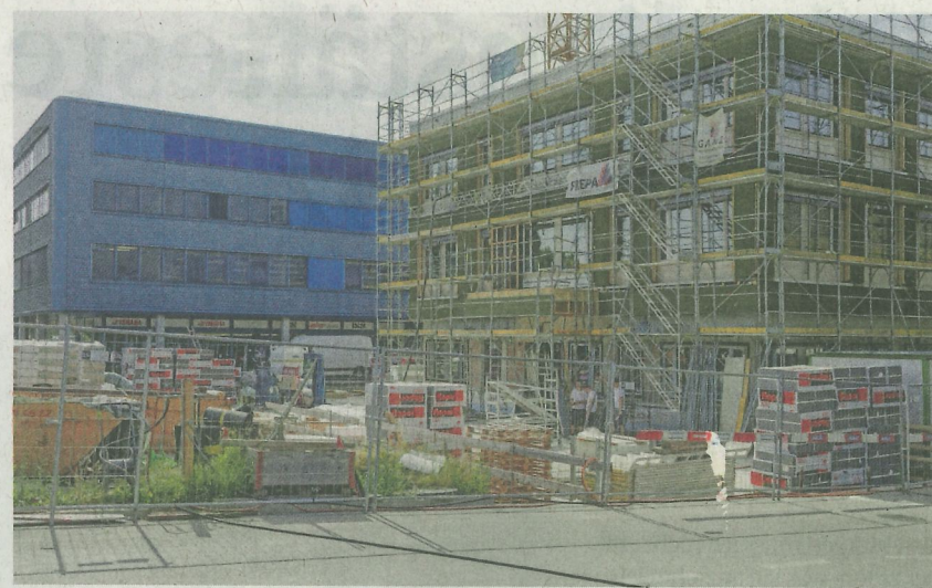
Alte Lys-Strasse: Hier entsteht eine Seeländer Polizeiwache.
