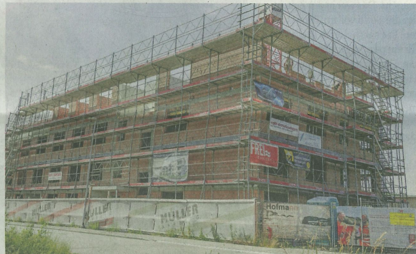
Bernstrasse: Hier entstehen Attikawohnungen, eine Einstellhalle und Grünflächen.
